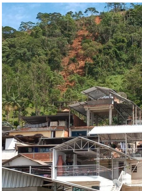
Figura 06: Deslizamento na Rua Bento Faria, Jardim Califórnia - Nova Friburgo, 2020. (Fonte: Redes Sociais)
