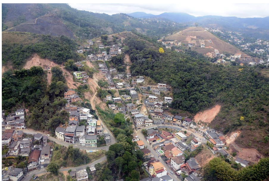
Figura 07: Deslizamentos no bairro Vilage, Nova Friburgo - 2011 (Fonte: SEMDEC)
