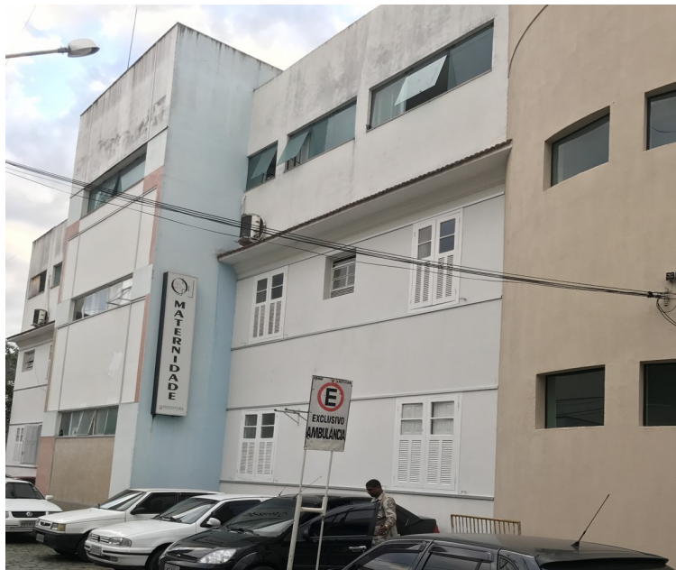
(fachada da Maternidade Municipal Dr. Mário Dutra de Castro)
