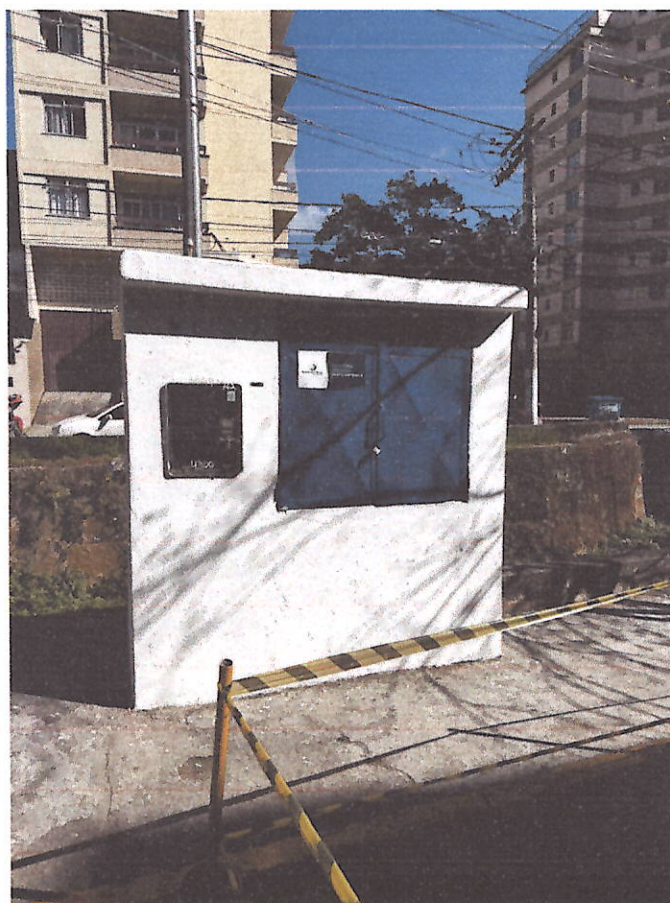
Figura: Estação Elevatória de Esgoto Santo Antônio II, próxima ao empreendimento, às margens do Rio Santo Antônio.
