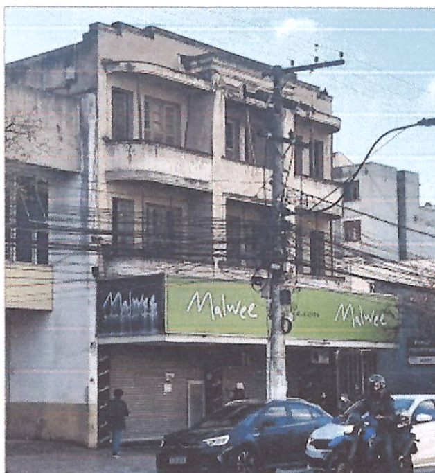
Figura: Fachada original da Edificação 218 (Av. Alberto Braune, nº 218), bem tombado a ser preservado e integrado ao empreendimento. Fonte: registro fotográfico do autor, 2026.
