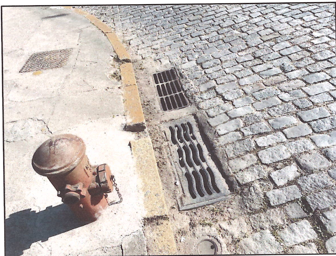
Figura 03: Bueiros com boca de lobo na Rua Zélia Santos Cortes. Fonte: autor, 2024.
