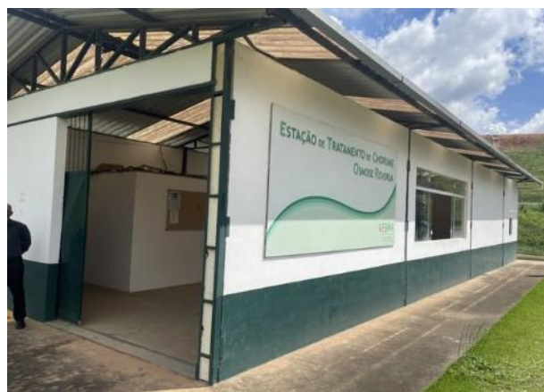
Figura 42: Estação de tratamento do chorume.
