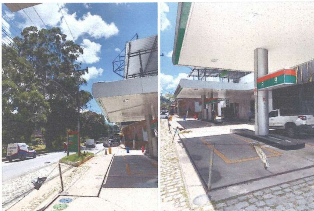
Figura 13 - Canaletas. Fonte: Master Ambiental.
