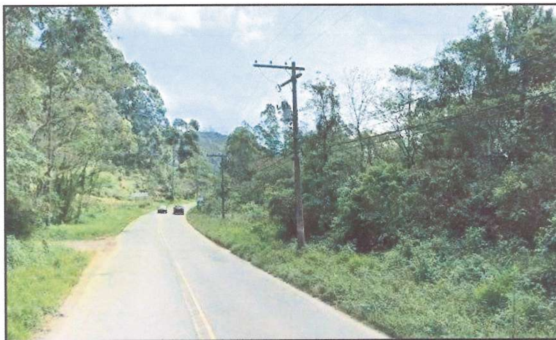
Figura 07: Rede pública de distribuição elétrica. Fonte: autor, 2021.
